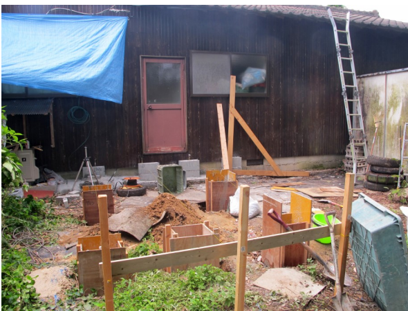
7月21日 基礎工事を始めました
