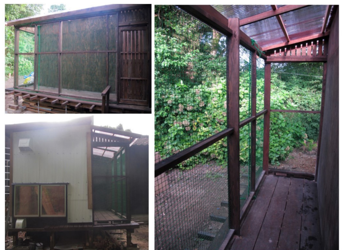
9月16日 ベランダネット張り終了
