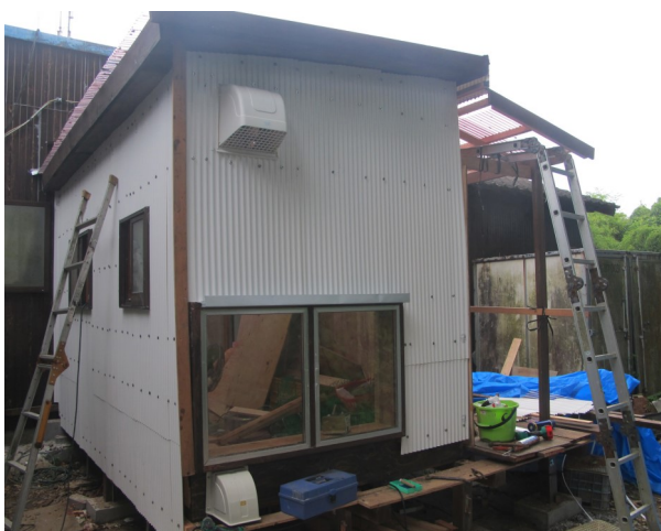
9月9日 外壁完成
